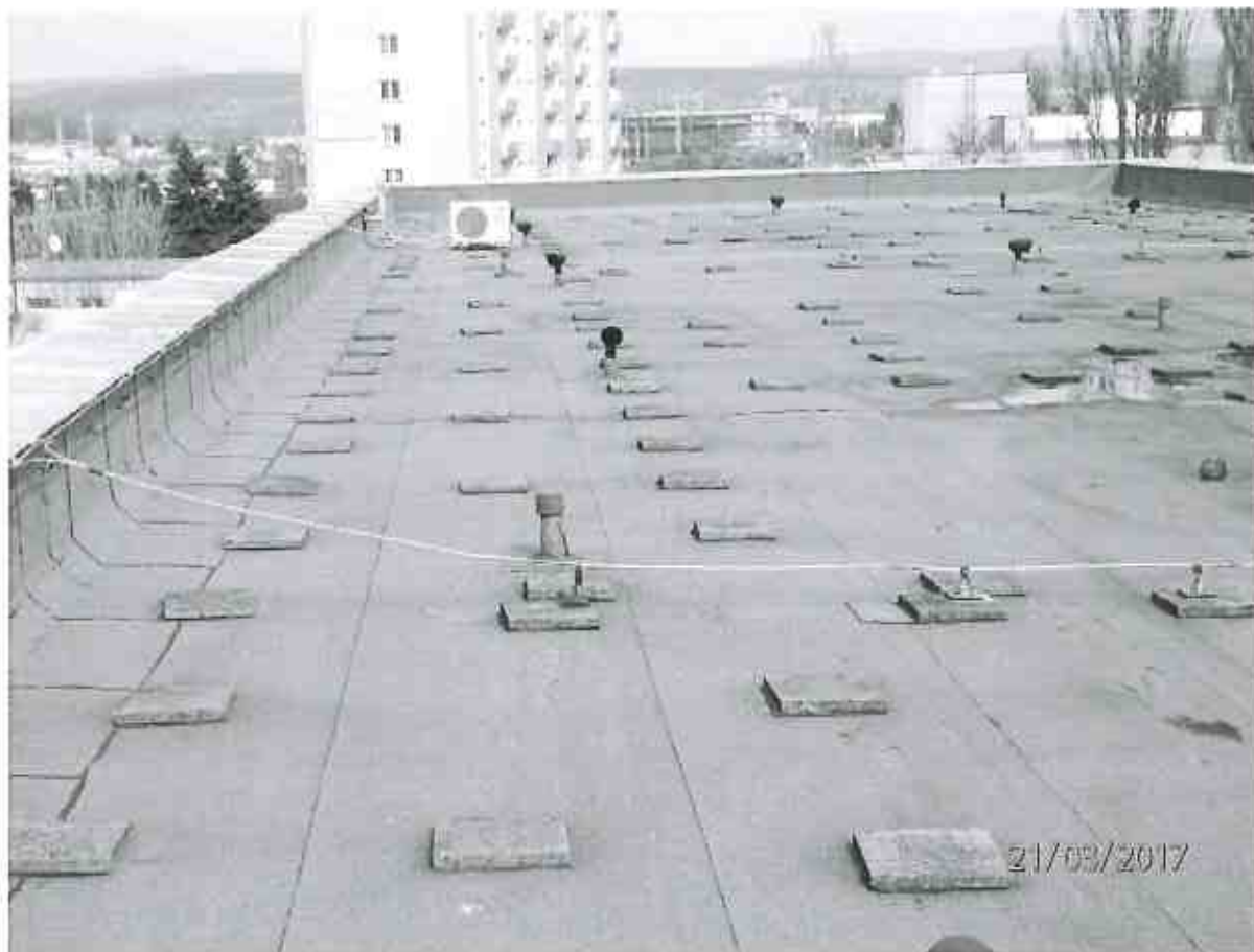
Část střechy A
